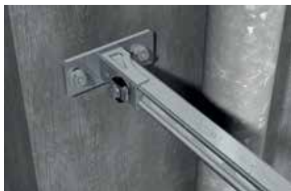
Szerelősín falra rögzítése
