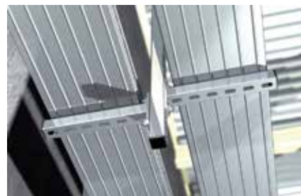
Kábeltálca konzolon
