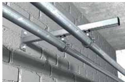
Könnyű csővezetékek rögzítése
