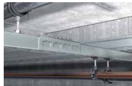
Hosszanti szerelősín csatlakozás
