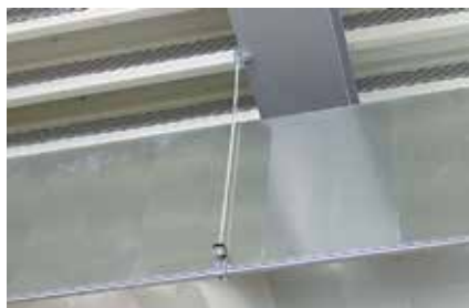
Légcsatorna függesztése acél gerendáról
