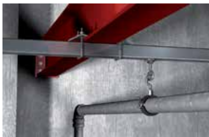
Szerelősinék rögzítése acélgerendákhoz
