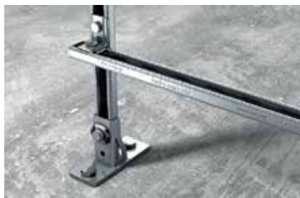
Szerelősín rögzítése padlóhoz
