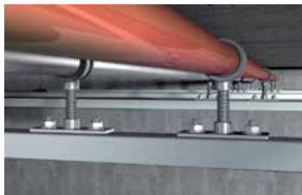
Alaplappal szerelt csővezetékek
