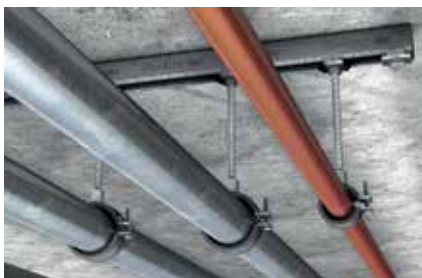
Csőrögzítések szerelősínekkel
