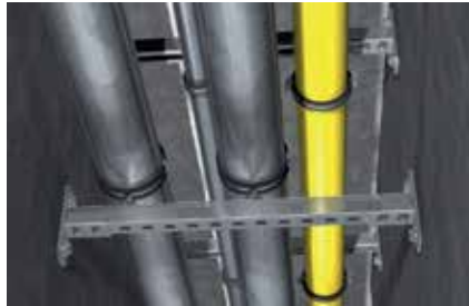
Csőrögzés menekülő útvonalaknál
