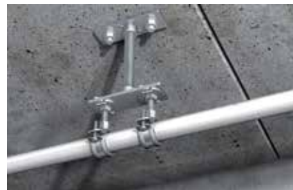
Műanyag cső fixpont szereléssel
