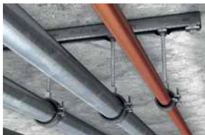
Csörögzés szerelősínnel
