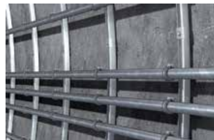
Szerelősínek falhoz rögzítéséhez
