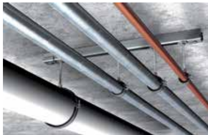
Könnyű függesztett csöveknél
