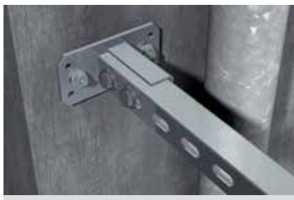
Áthidaló szerelés aknában
