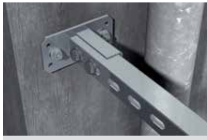
Áthidaló szerelés aknában
