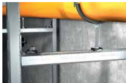
Csővezetékek keretszerkezeteken
