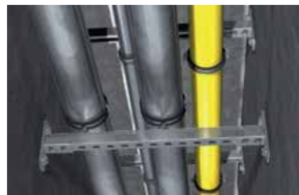
Csörögzítések menekülő utaknál
